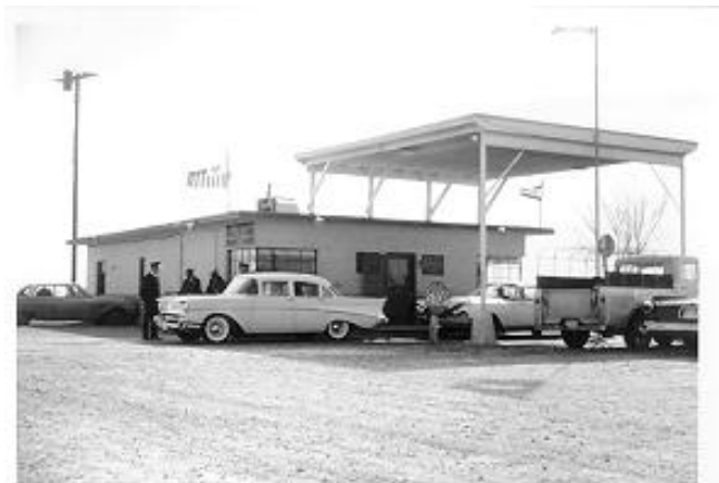
Figura 21. Fotografía antigua de la garita de inspección. El Paso Ysleta Border Inspection Station in 1962 (U.S. Customs Service). Fuente: http://www.customs.treas.gov
