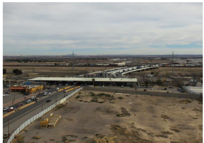
Figura 23. Fotografía aérea tomada con dron en recorrido de campo, de la entrada al Puente Ysleta-Zaragoza desde México, 2016. Fuente: elaboración propia.
