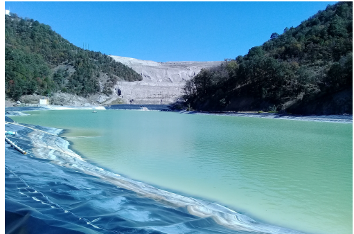
Foto 4. La foto muestra el sitio donde se ubicaba la vivienda del sujeto 1 totalmente inundado por el agua envenenada.
