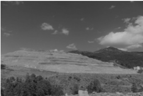
Foto 3. La foto muestra la zona de demolición que ocasionó el desplazamiento de los habitantes del sitio denominado "Bayoreca".
