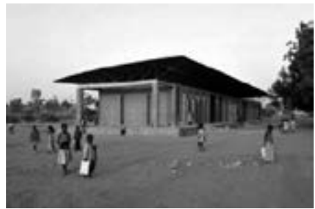
Imagen 15. Escuela en Gando (África), de Diébédo Francis Kéré.
