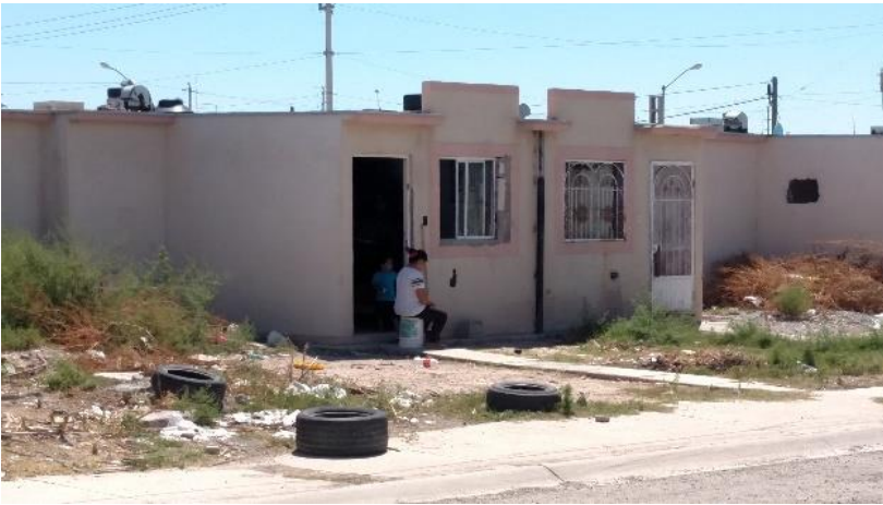
Figura 1. Vivienda abandonada y vandalizada en Senderos de San Isidro. Fuente: Peña, 2016.
