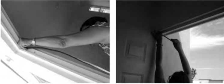
FIGURA 5. Sellado de puertas en viviendas económicas en Mexicali.
