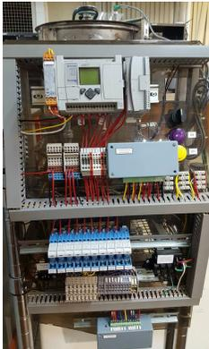
**Figura 7** Módulo de automatización e internet de las cosas
