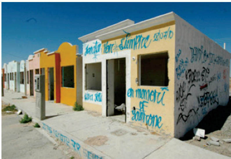
Figura 2. Situación de la vivienda deshabitada
