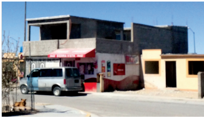
Figura 16. Segundo piso agregado a casa
