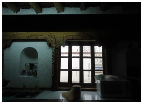
La imagen 6, muestra el interior de la cocina, en la fotografía se alcanza a ver parte del techo con las vigas de rollo, la trabe de madera y el nicho dentro del muro. La técnica del uso de adobe en los muros. Las techumbres hechas con rollos, carrizos, paja y terrado, las orientaciones son aportaciones indígenas al espacio habitable; así como la disposición espacial es europea.
