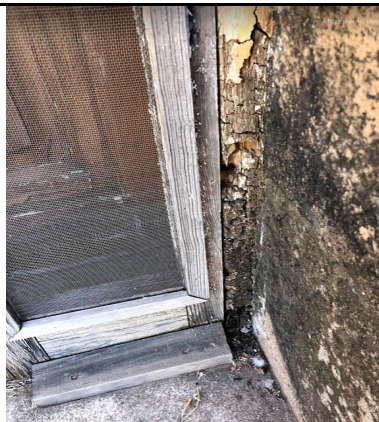
Figura 4. Marco de madera deteriorado por bacterias celulolíticas. Iglesia Ávalos Chihuahua, Chih.
