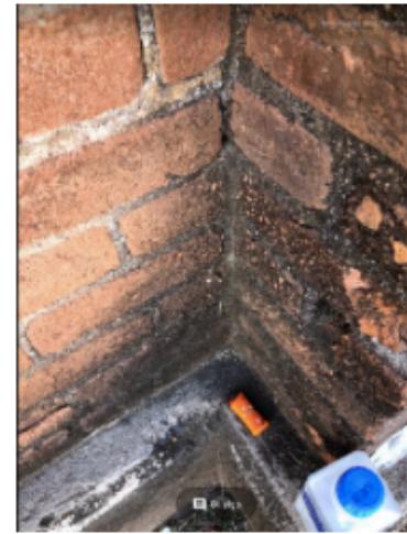
Figura 3. Liquen de ladrillo en escuadra de pared color marrón café (muestra en sol. salina).
