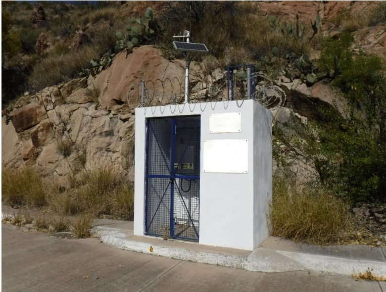
Figura 32 Entrada principal hacia la zona de acceso a visitar los detalles de construcción de cortina
