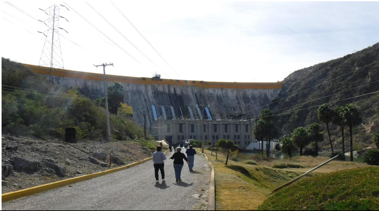
FIGURA 1 CORTINA DE LA PRESA DE CONCRETO CICLÓPEO, CUARTO DE MAQUINAS DEL SISTEMA DE LA CENTRAL HIDROÉLECTRICA SISTEMA DE 6 TUBERIAS 2 COLOR AZUL SUBIDO CNA Y 4 AZUL PALIDO PARA GENERACIÓN DE ENERGÍA ELÉCTRICA (CFE). CUARTO DE TURBINAS.
