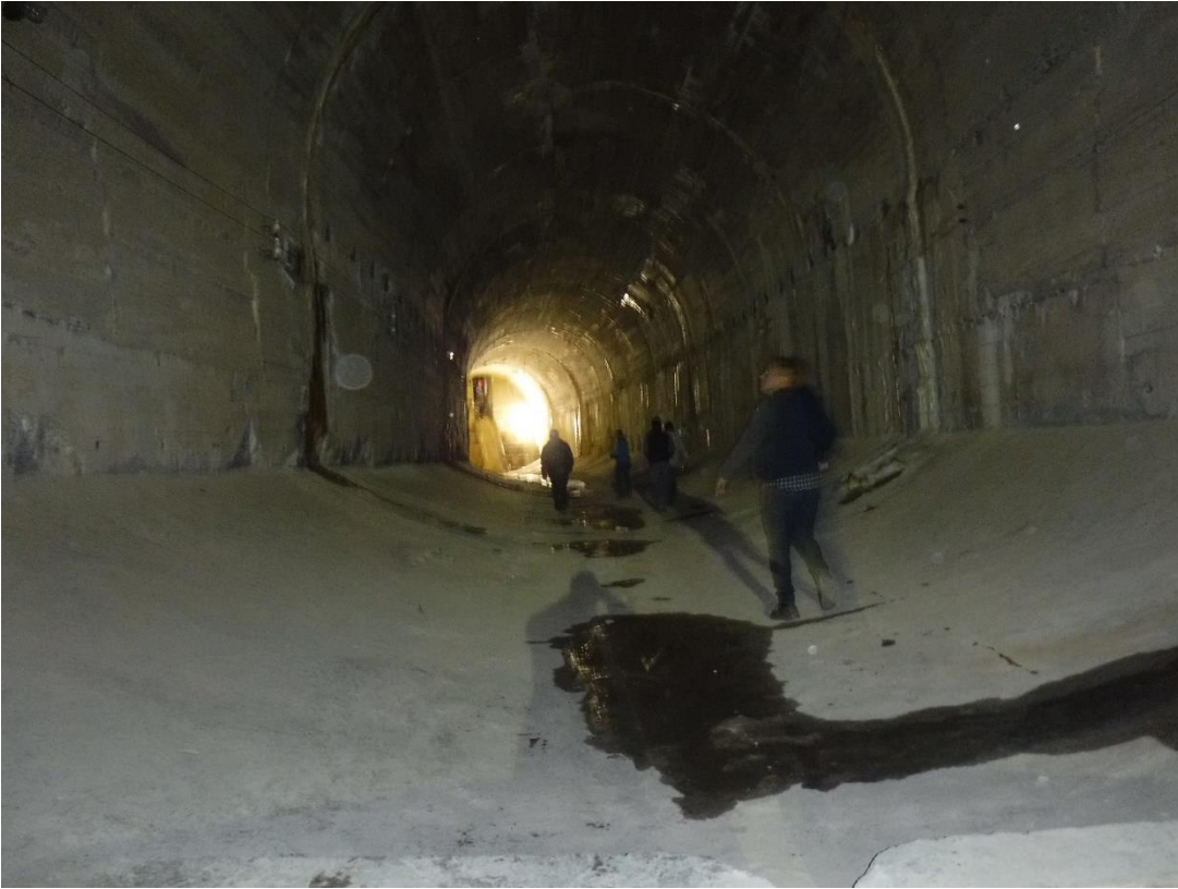
Figura 8 parte inicial del sistema de túnel revestido de concreto al fondo se observa el inicio de los 345 escalones de un peralte aproximado de 50 cms
