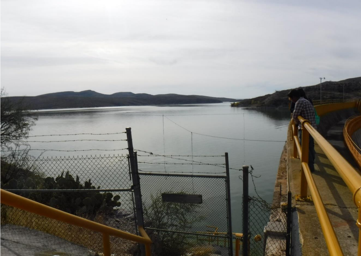
Figura 10 Vista Oeste de la cortina donde se aprecia el vaso de almacenamiento
