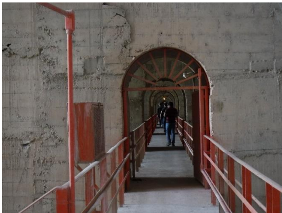
Figura 35 detalle de pasillos y escaleras para tener acceso al cuerpo del sistema de operación de los tubos de desfogue, en el video de la figura se puede las escaleras y los detalles del acceso interior a la cortina.
