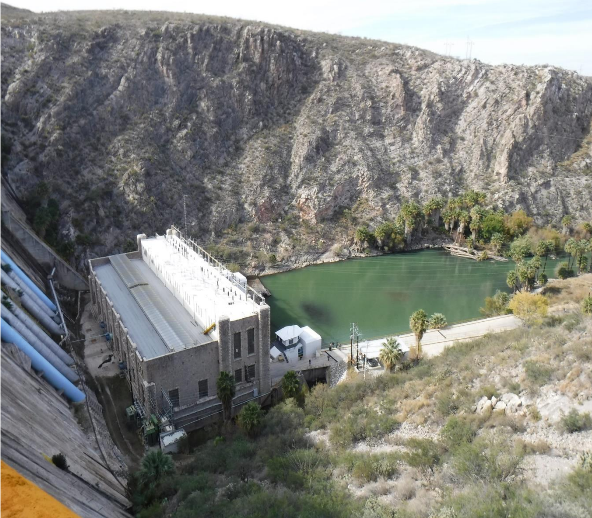
Figura 12 Vista Este de la cortina, se aprecia macizo de anclaje lago donde se para descarga del agua y conducción a la zona de aguas abajo a la zona de riego.
