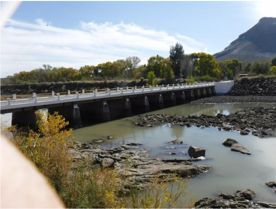
Figura 27 Sistema de compuertas aguas debajo de la presa las Virgenes.
