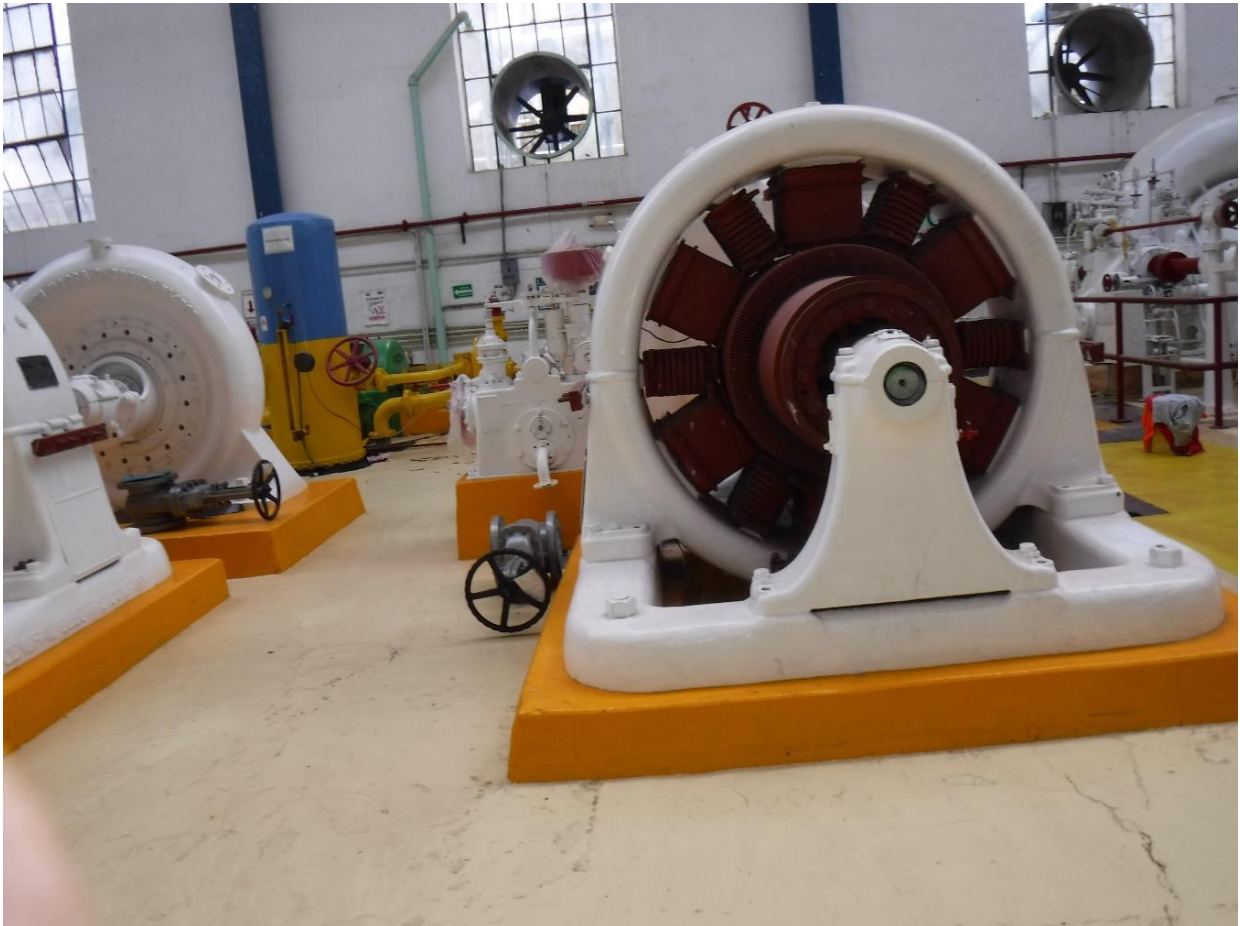
Figura 3 Turbina número 3. MARCA Esher Wyss; serie: 4759 ; tipo Francis, horizontal con doble rodete; potencia 8765 hp.
