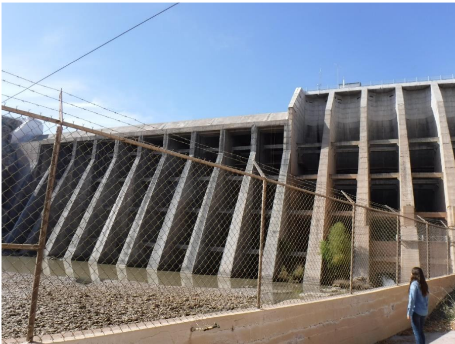
Figura 33 Panorámica de la cortina de la presa, se aprecia la única compuerta que está en el momento operando. Los tubos de disipación de energía están distribuidos en 14 compuertas.
