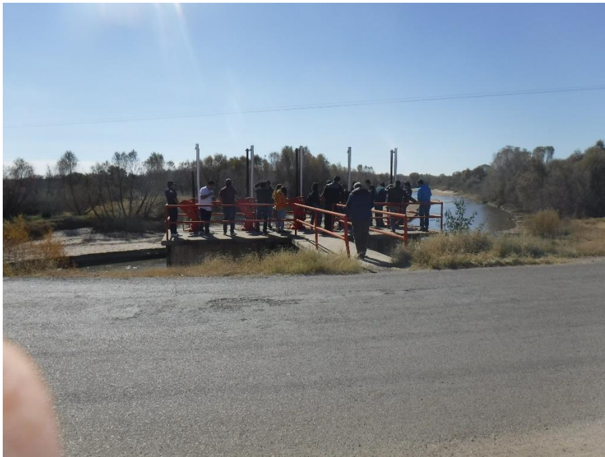
Figura 3 panorámica Aguas arriba cauce natural río Conchos y escala de niveles
