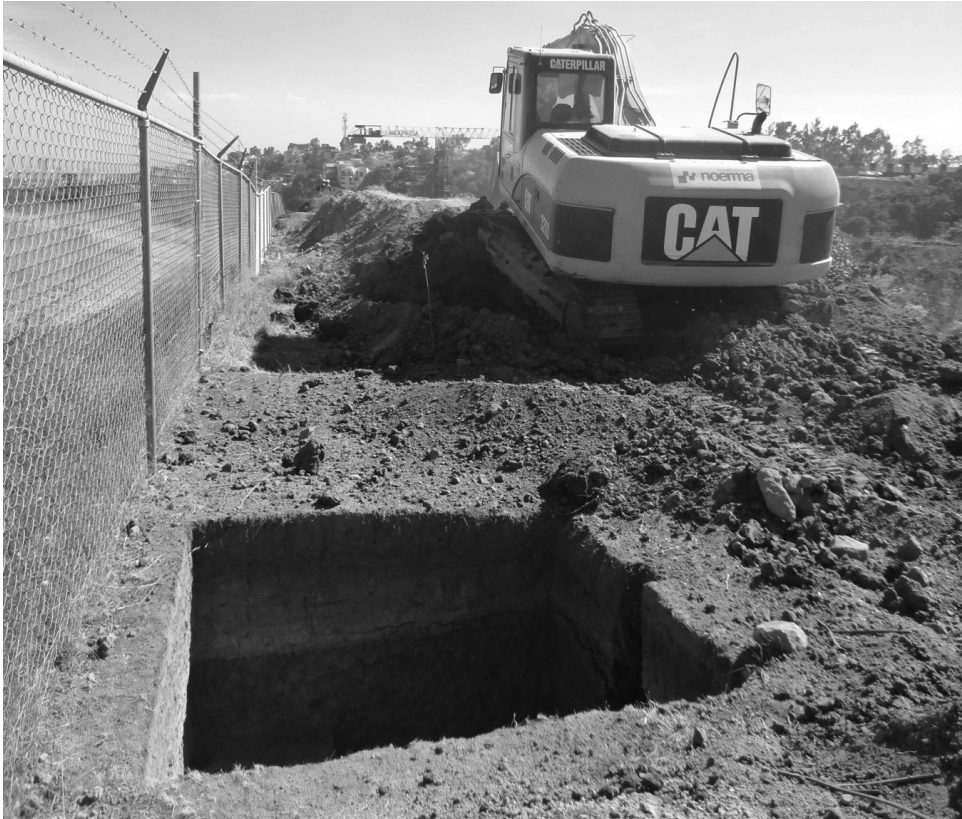
Figura 2. Maquinaria pesada trabajando de manera simultánea al proceso de excavación durante el Salvamento Supervía Poniente, una muestra de la emergencia en arqueología. Fotografía: David Muñiz, 2009.
