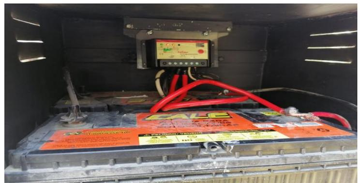
Figura 9 Luminaria LED Solar y Controlador
