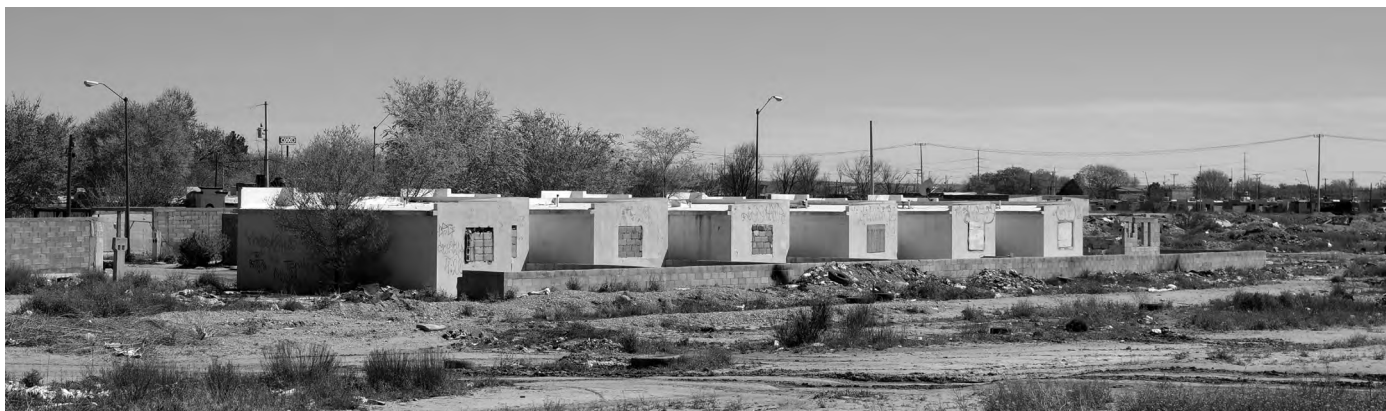
Figura 22. Fotografía de conjunto de viviendas de promoción social abandonadas. Casas abandonadas situadas en la periferia de la colonia Riberas del Bravo en Ciudad Juárez. Viviendas de tamaño mínimo, seriadas, en este caso saqueadas y con las ventanas tapiadas.
