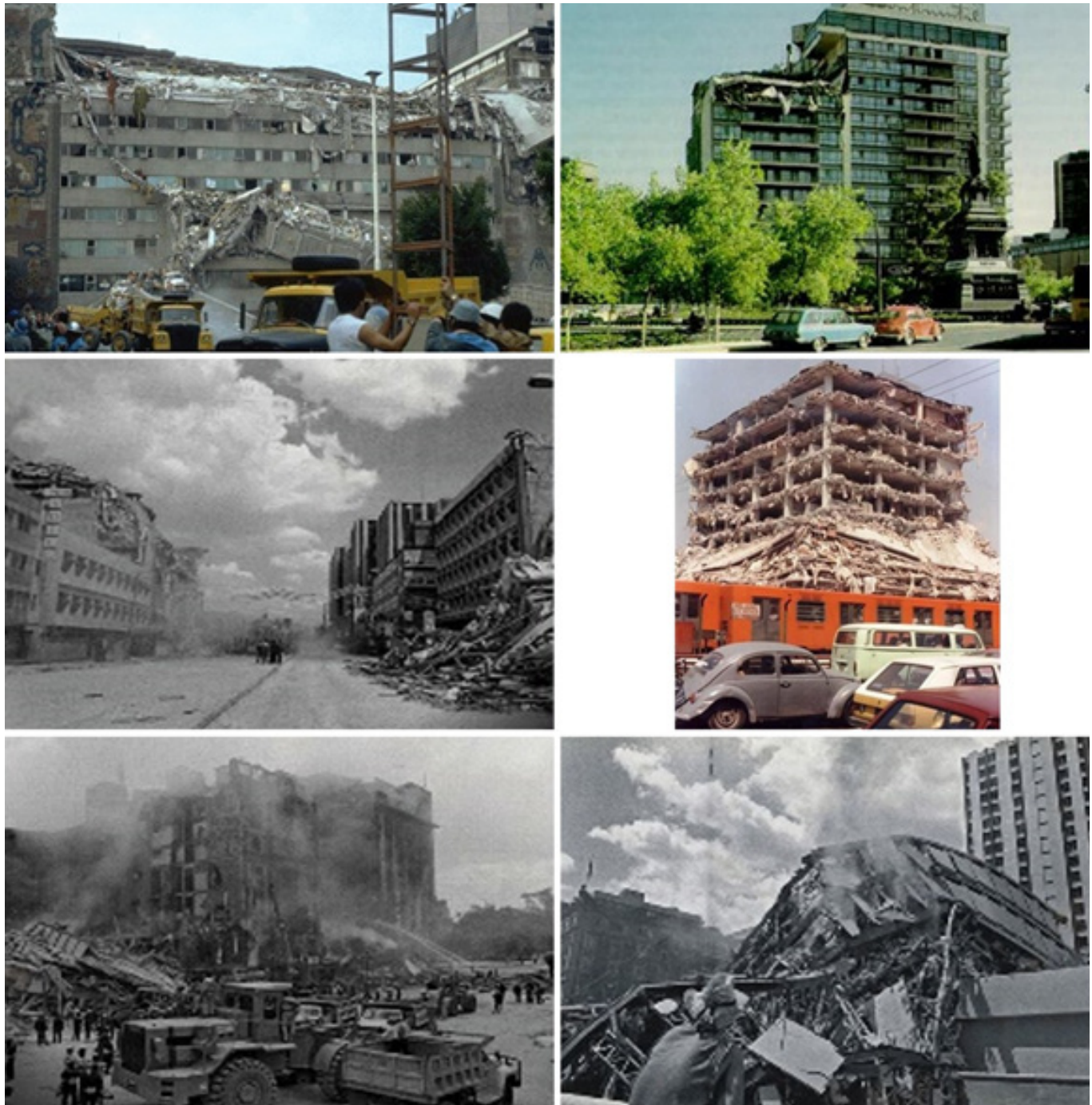
Figura 7. Daños provocados en la Ciudad de México por el sismo ocurrido el 19 de septiembre de 1985 (Tomado de Servicio Sismológico Nacional, 2017b).
