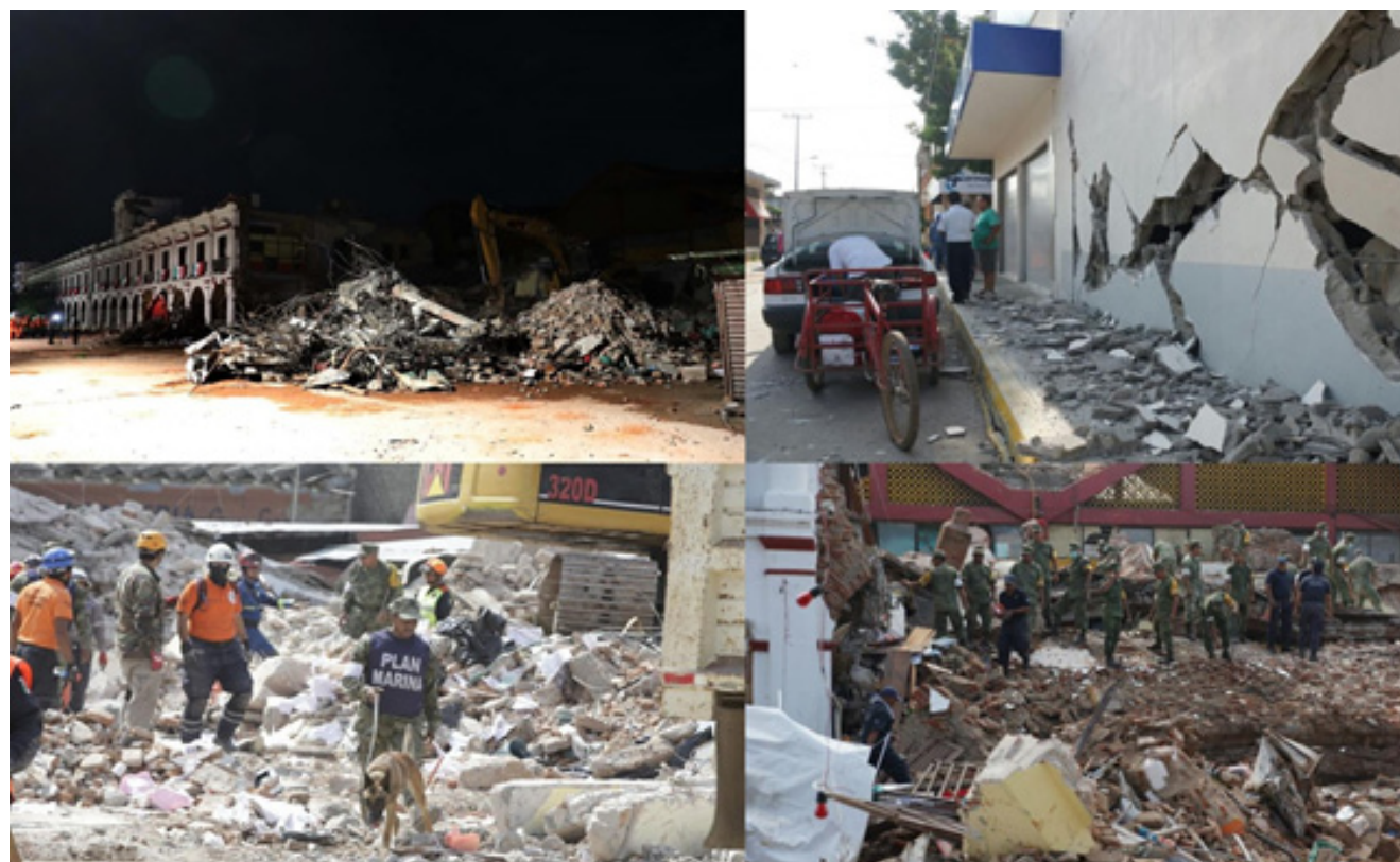
Figura 6. Daños provocados por el sismo ocurrido el 7 de septiembre de 2017, en la comunidad de Juchitán, Oaxaca (Tomado de http://www.eluniversal.com.mx ).
