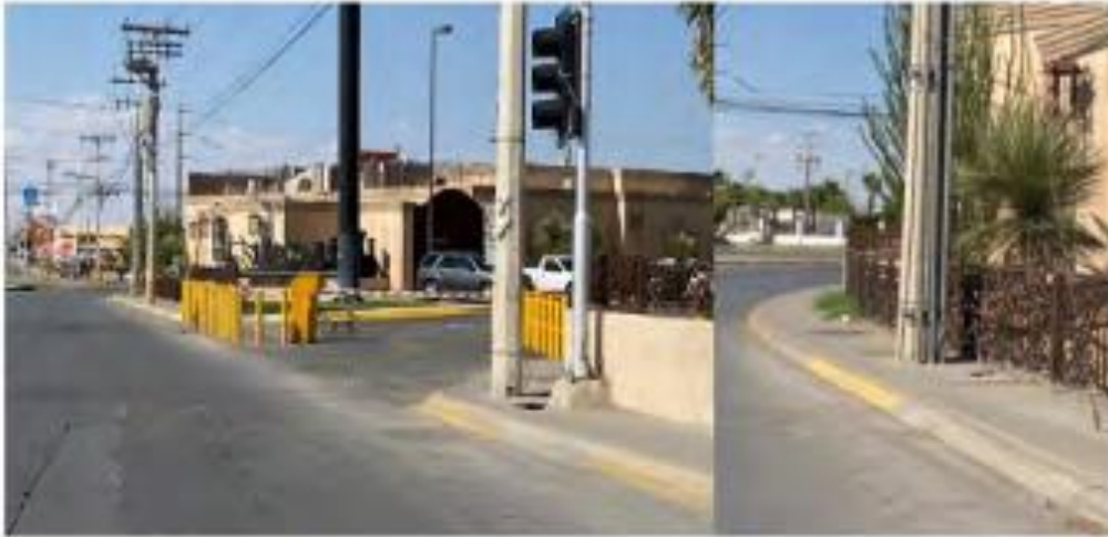
Figuras 15 y 16. Acero de la vialidad en avenida Paseo de la Victoria esquina con la avenida Ejército Nacional. Ambas de tráfico constante
