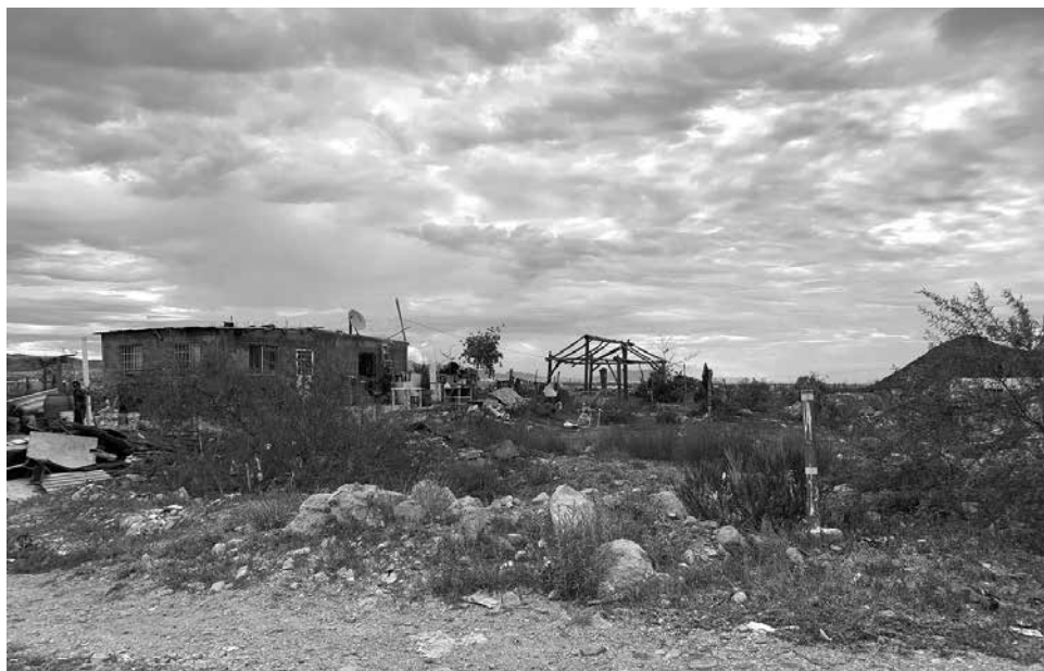
Figura 2. Habitación en la periferia de Paso del Norte (Chihuahua) desarrollada con autoconstrucción, práctica más que común en la colonia.
