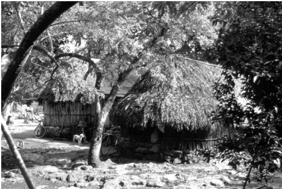
Figura 1. Cocina maya en primer plano, con muros de kololché por el cual el humo del fogón sale de la cocina. Nunkiní, Campeche, 2001. Foto: Aurelio Sánchez Suárez.
