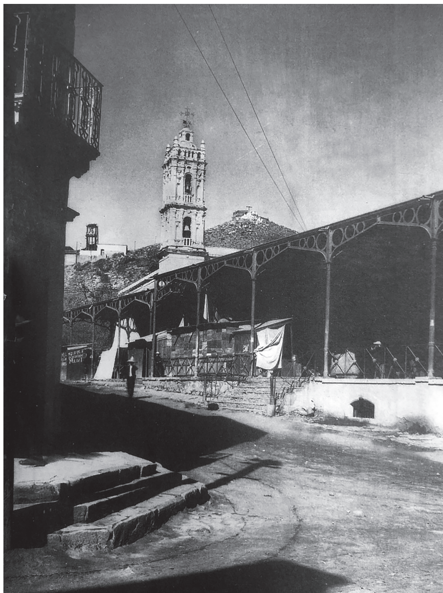
Fig. 3. Mercado Hidalgo en Parral. Tomado de Prieto (2001). Las piezas metálicas se trajeron desde San Francisco, California, e incluían: 48 columnas, 64 medios arcos y 16 largueros de columna, todo en fierro vaciado, y 100 soportes de fierro dulce, gualdrillas, vigas, lámina de fierro para techumbre, persianas de fierro laminado, además de 18 puertas de madera.
