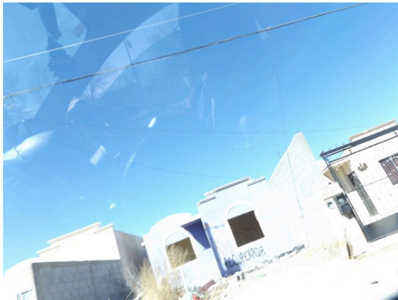
Imagen 4: Vivienda recuperada por la compañía constructora para ser reconstruida y vendida nuevamente
