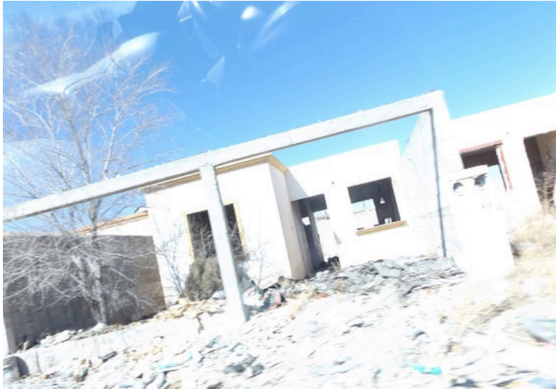
Imagen 1: Vivienda abandonada y deconstruida
