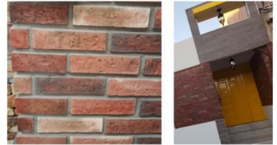
IMAGEN 8. EJEMPLOS DE DENOTACIÓN Y CONNOTACIÓN. IZQUIERDA: MATERIAL DE FACHALETA DE LADRILLO; DERECHA: IMAGEN DE FACHADA EMPLEANDO FACHALETA DE LADRILLO
