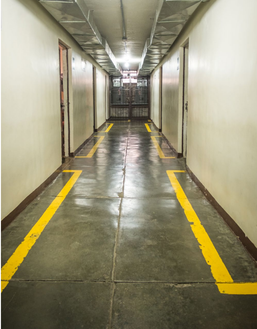
Fotografía 13. Pasillo, primer piso, Cereso de Guachochi
