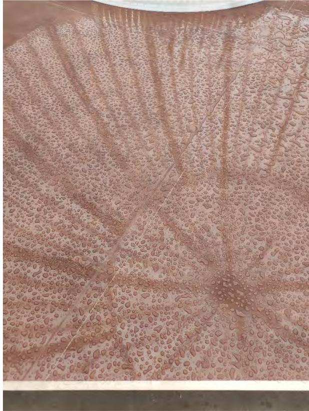
Fig. 29. Película plástica para reforzar la resistencia al agua a la plataforma y aumentar el tiempo de vida de la plataforma; se observa la impermeabilidad de la cubierta ante la presencia de agua de lluvia.
