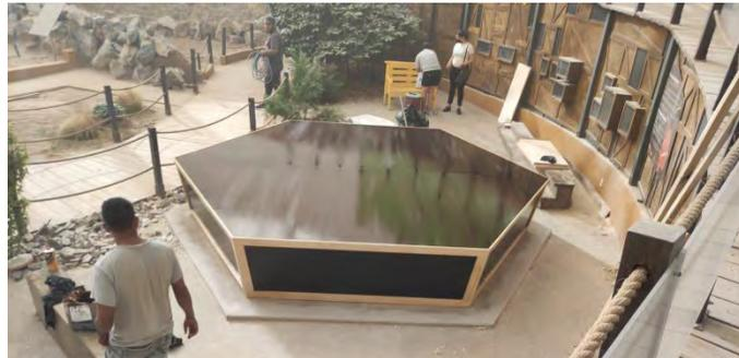
Fig. 20. Plataforma hexagonal del *Péndulo de Foucault*, previo a un recubrimiento de poliuretano de y película plástica (se aprecia el barandal hexagonal y estructura interna de plataforma).
