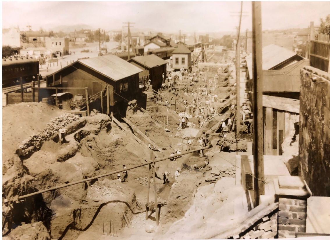
Figura 4. Primeros trabajos de canalización, dirigidos por el ingeniero Francisco J. Ramírez, ca. 1930 (AHCILA, Gaveta 32, Exp. 1834).
