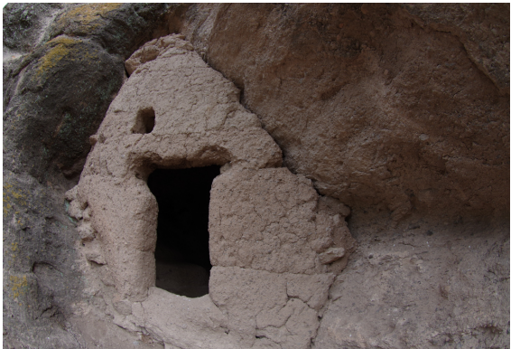
Figura 17. Cueva El Solito. El muro de tierra que tapa la cueva, donde se encuentra una entrada y una ventana pequeña.
