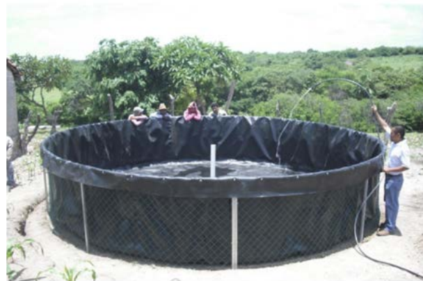
Figura 2. Mantenimiento a estanque seleccionado para pruebas. Fuente: Elaboración propia.
