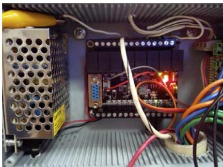
Figura 5. Cableado del PLC.
