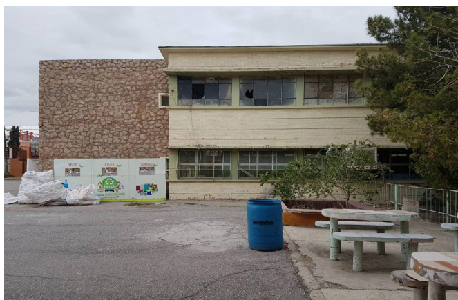
Imagen 2. Vista de fachada poniente, parte sur del edificio
