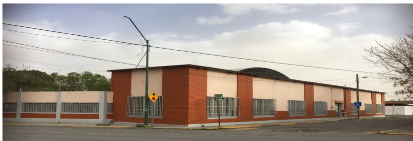
Imagen 5. Fachada Poniente. Calle República del Salvador. Actual acceso de la escuela primaria.
