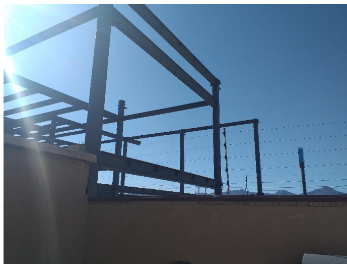
Figura 9 Obra colindante con algunas viviendas del lado oeste del fraccionamiento
