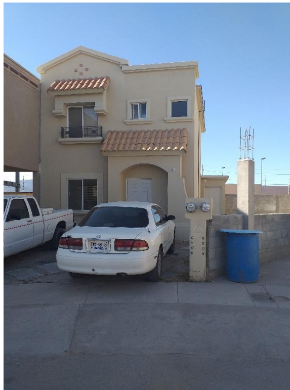
Figura 1 Frente de la construcción (lado este)
