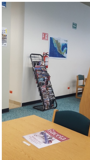
Figura 2. Ubicación actual de revistero junto a extintor.
