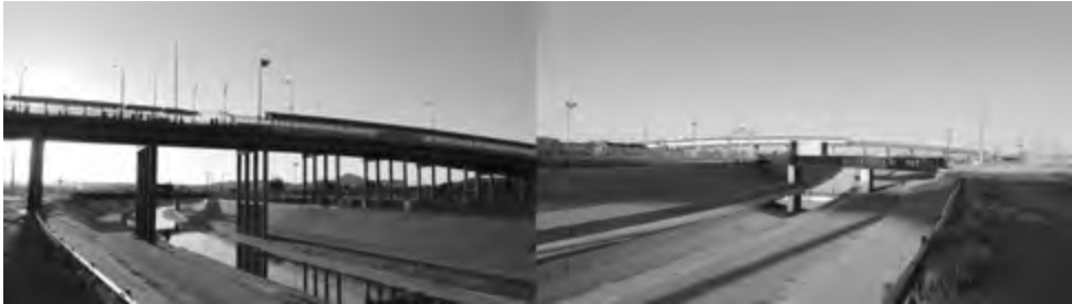
Zona de cruce Puente Paso del Norte (izquierda), Puente Stanton (derecha). Fotografías tomadas en recorrido de campo, 2016.
