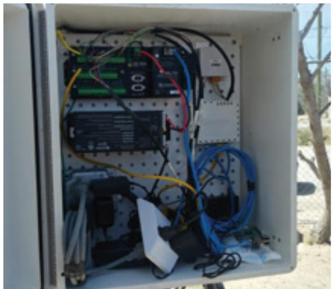
Para crear la conexión, se optó por usar un sistema de VPN PPP para facilitar una conexión segura a los sistemas internos de la universidad. Por medio de esta conexión, se provee una IP estática interna dentro del subdominio de la universidad para no solicitar una IP estática al ISP local.
