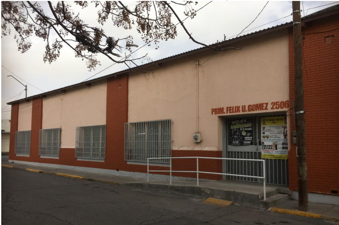
Imagen 2. Vista cercana de Fachada Poniente. Actual acceso de la Escuela Primaria. Fuente Hernández Pérez, 2018.
