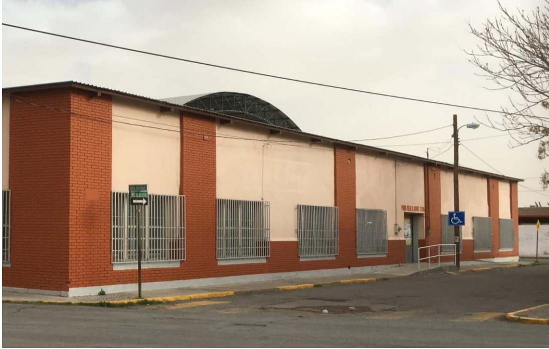
Imagen 1. Fachada Poniente. Calle República del Salvador. Actual acceso de la Escuela Primaria. Fuente Hernández Pérez, 2018.
